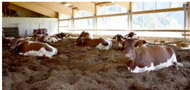
Höchster Kuhkomfort ist im Kompoststall garantiert - südseitig sorgen viele offene Flächen für viel Licht und frische Luft.
